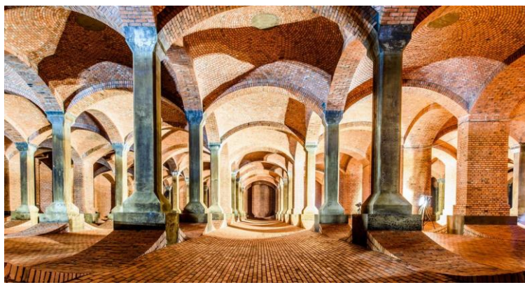
Ryc. 13. Podziemne zbiorniki wody pitnej (tak zwana katedra) na Stokach — Zakład Wodociągów i Kanalizacji w Łodzi, ulica Pomorska 246A Źródło: https://lodz.pl/galeria/podziemna-katedra-na-stokach-tajemnicze-miejsce-do-ktorego-nie-wejdiesz-zdjecia-57194/?imgNum=7&cHash=e48a313807bc050dfa1f1515a1842010 [dostęp: 25.10.2023 roku]
